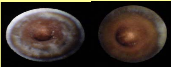
Водопроводные краны в больницах
